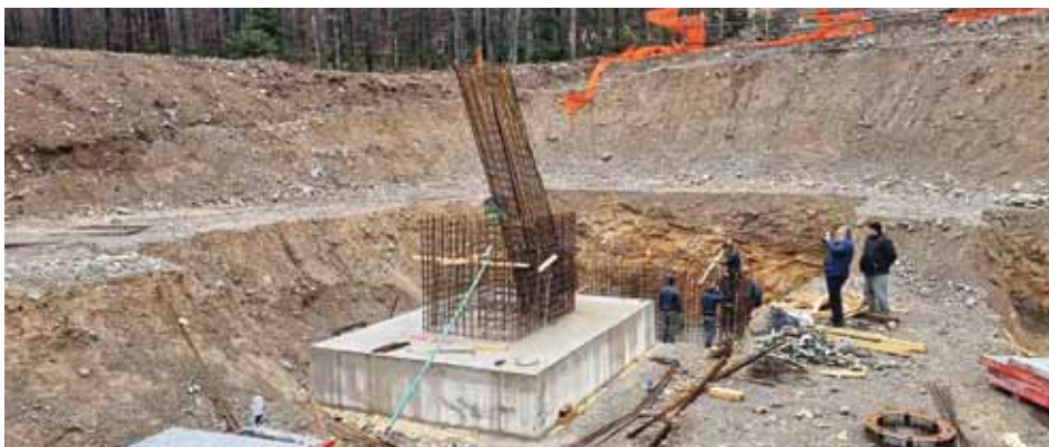
Radovi na izgradnji žičare Radeševo i kako bi trebala izgledati
