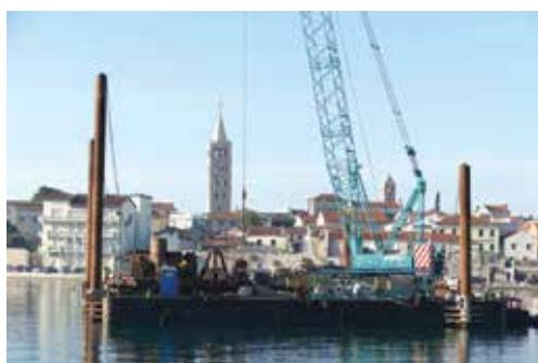
Privezivanjem za rapsku rivu barže "Fiumanka" opremljene 70-metarskom dizalicom nosivosti 180 tona te pratećim strojevima i objektima, započeli su dugoočekivani radovi na rekonstrukciji luke Rab
