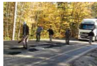
Rekonstrukcija ceste Lič - Lukovo
