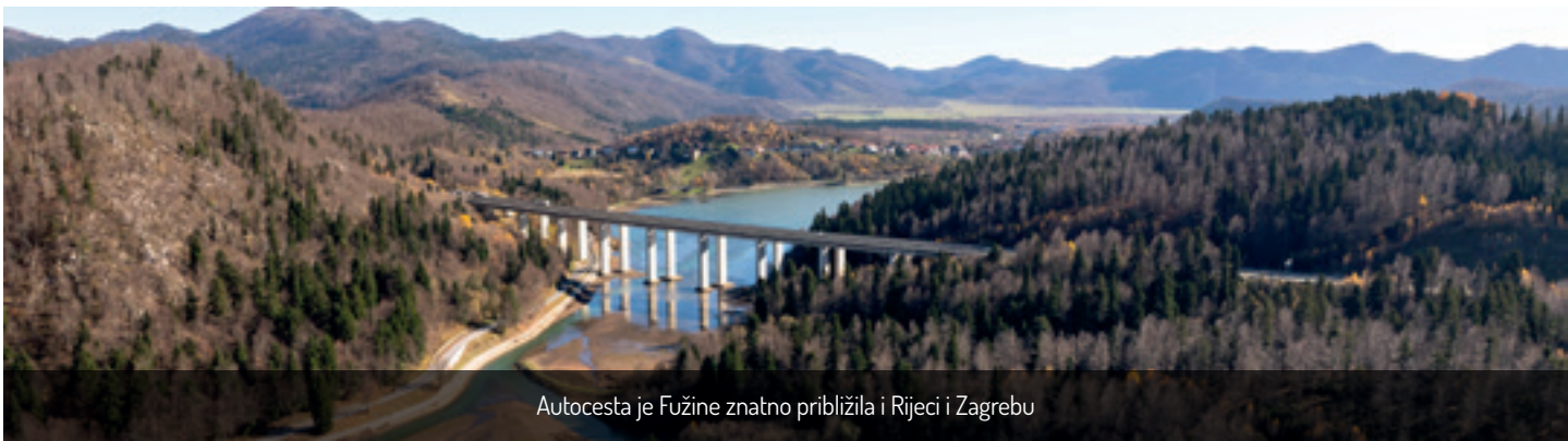
Izgradnja obilaznice naselja Fužine bit će gotova na proljeće
