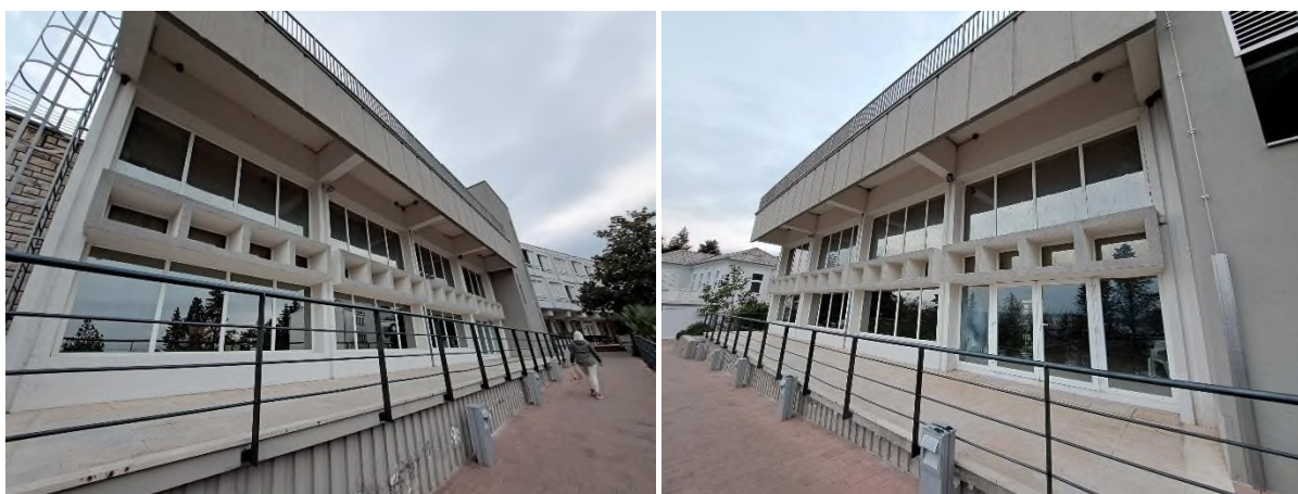
Slika 13. Postojeće stanje izgled vanjskog dijela bazena
