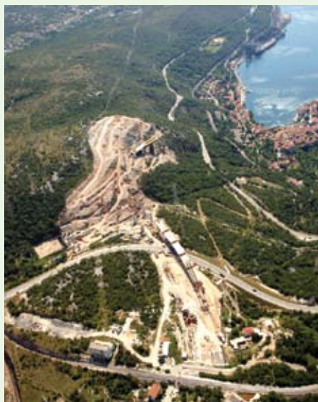
Brza cesta Orehovica – Draga – Sv. Kuzam/ Bakar snimljena tijekom gradnje 2006. godine
