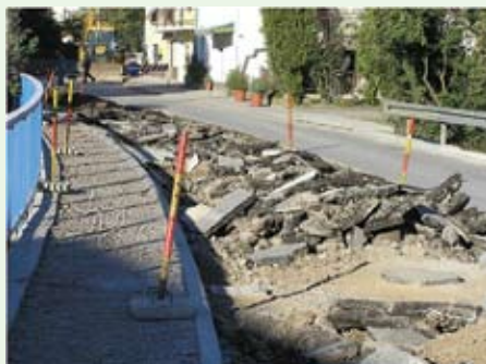
Sanacija kolnika na županijskoj cesti 5019 u Spinčićima
