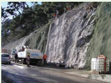
Uređenje potpornog zida na županijskoj cesti 5051 na Preluku
