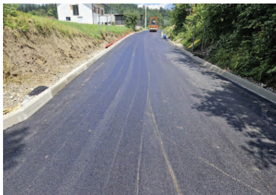
Obnovljeni i prošireni kolnik ceste na lokalitetu Smrečje - Vode
