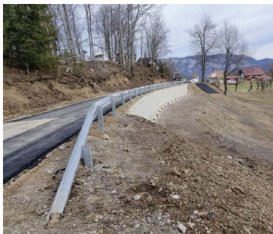
Sanirano klizište na lokalitetu Hrib
