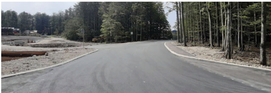
Nova kolnička konstrukcija na ŽC 5030, lokalitet Platak
