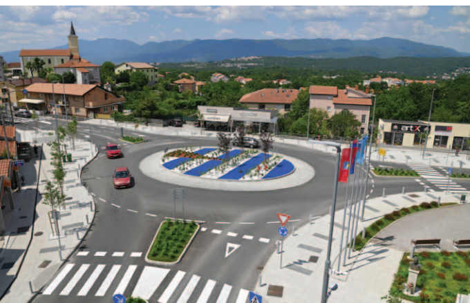
Sanirani kolnik i novoizgrađeni kružni tok u Viškovu
