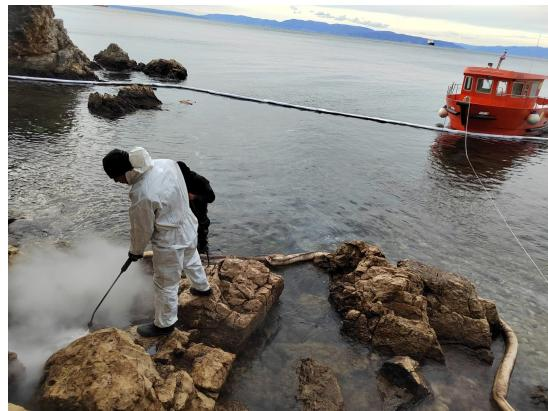
Stijene se čiste s topлом vodom zagrijanu na 120 C koja se raspršuje visokotlačnim peračem pod pritiskom od 200 bara
