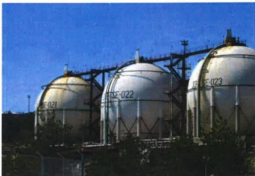
Slika 19. Kuglasti spremnici UNP-a: SE-021, SE -022, SE-023; kapaciteta 5 000 m<sup>3</sup> svaki
