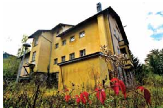
Nekadašnji vojni kompleks Šiljar zove na obnovu
