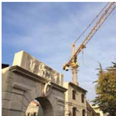
Gradska vrata i dizalica - U obnovi palače Moise sudjeluje dizalica visoka 30 metara s „rukom“ dugom 60 metara, najveća takve vrste u Hrvatskoj
