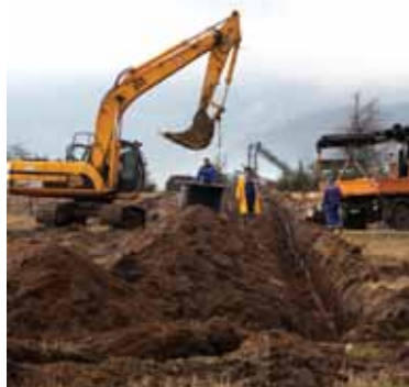
Djelatnici HEP-a odmah su krenuli u obnovu mreže sustava elektro opskrbe koju su odlučili izgraditi - pod zemljom
