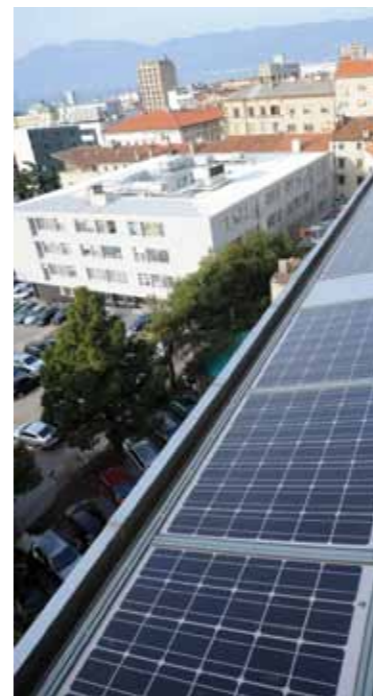
Fotonaponskim ćelijama na fasadi namiruje se dio potreba za električnom energijom
