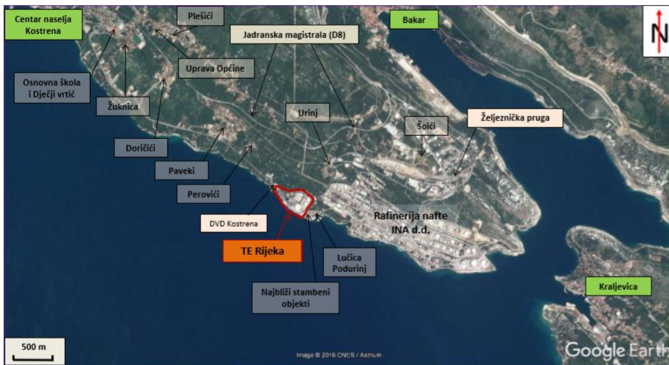
Slika 5. Makrolokacija tvrtke HEP Proizvodnja d.o.o. – TE Rijeka
