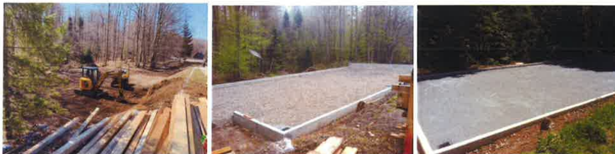
Radovi na izgradnji četverostaznog bočališta
