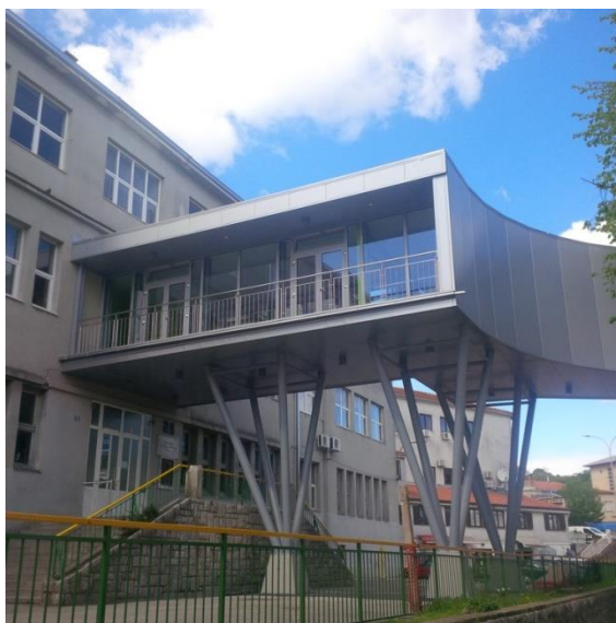
Slika 3: Pročelje Osnovne škole „Dr. Andrija Mohorovičić“ (postojeća građevina)
