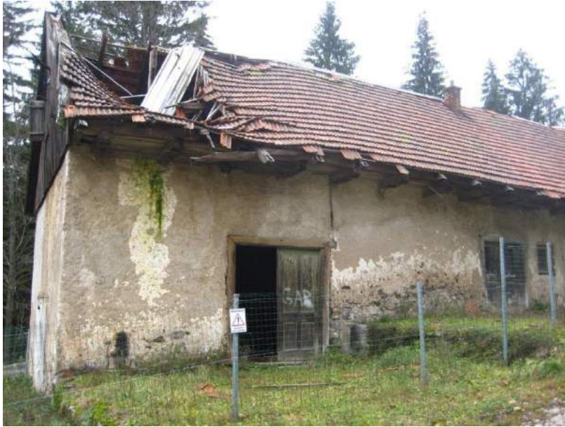
Trenutno stanje zgrade prije obnove i stavljanja u funkciju
