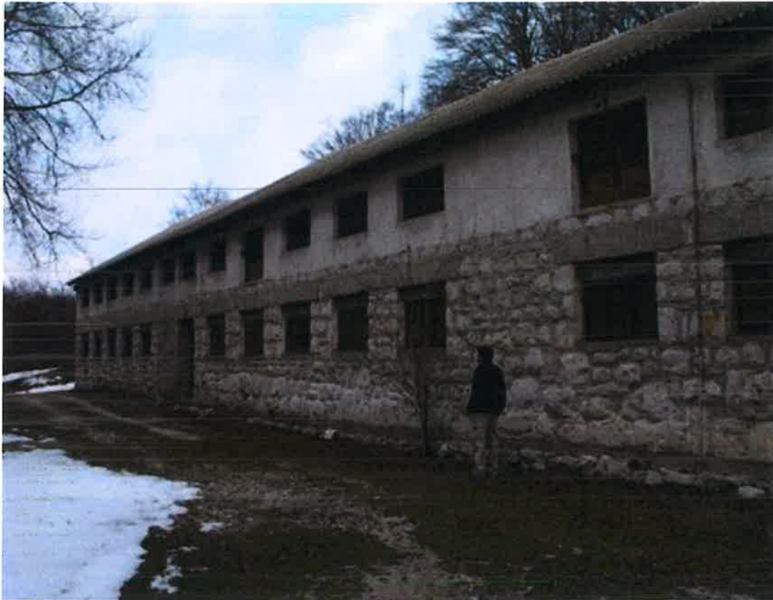
Postojeće stanje objekta Visitor centra
