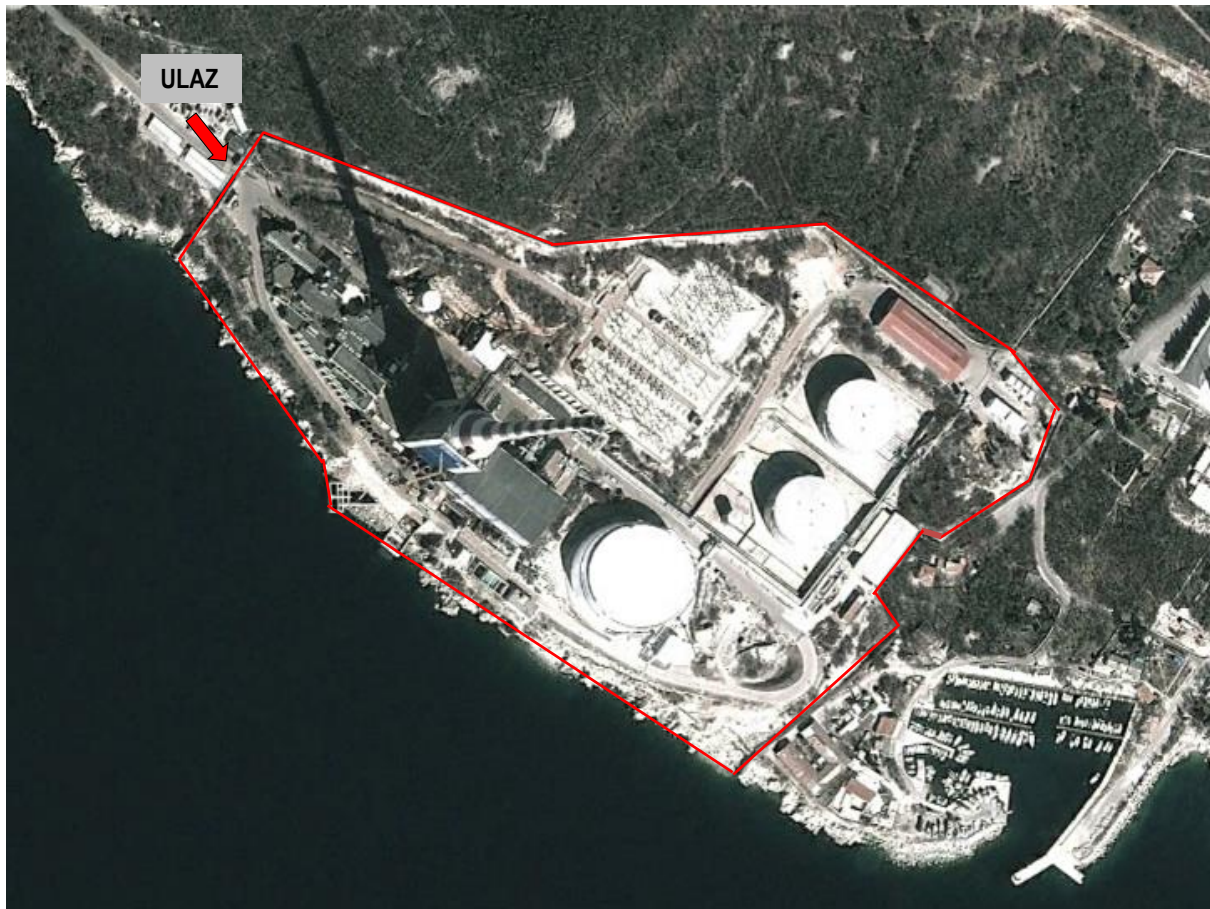
Slika 7. Mikrolokacija područja postrojenja TE Rijeka operatera HEP Proizvodnja d.o.o.
