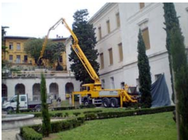
Radovi na terasi iznad Lapidarija
