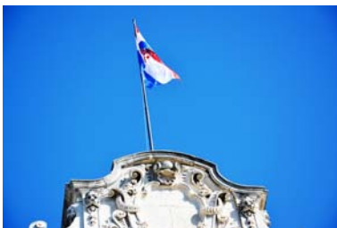
Obnovljen stup na vrhu Guvernerove palače
